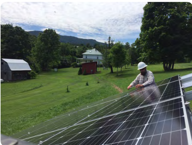
Instalador coloca paneles en la granja de de Rafe Pomerance, en West Virginia
